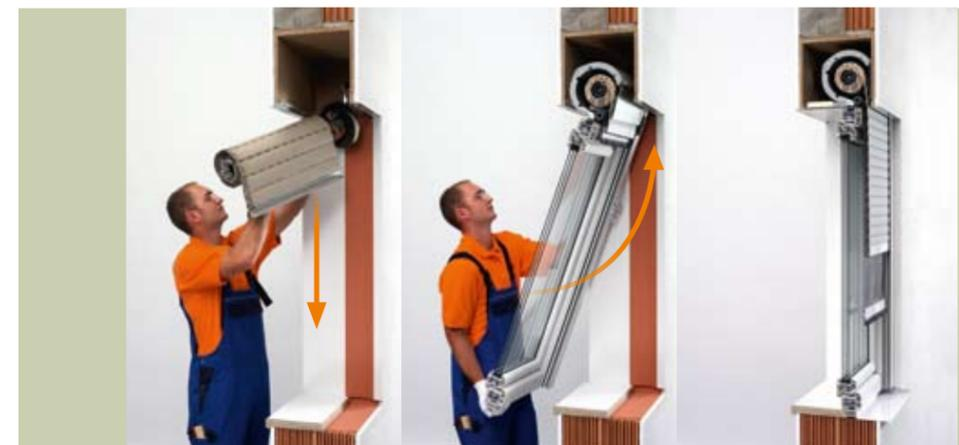
Renovierungstipp: Effiziente Komplettlösung – Das neue Fenster wird in einem Schritt mit dem Rollladensystem TERMO von ROMA montiert.
