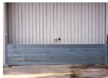
Extrabreite Montage Wandöffnung eines Garagentores
