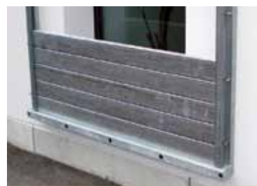
Montage vor der Wandöffnung mit zusätzlichem Schwellenprofil
