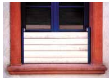
Montage in der Fensteröffnung nachträglich farblich passend lackiert
