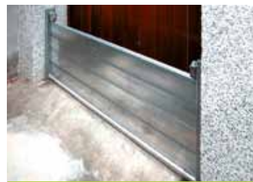
Montage in der Wandöffnung auf dem Boden aufsetzend
